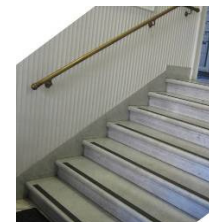
Scalini con strisce antiscivolo in contrasto cromatico per la massima percezione sia tattile che visiva
